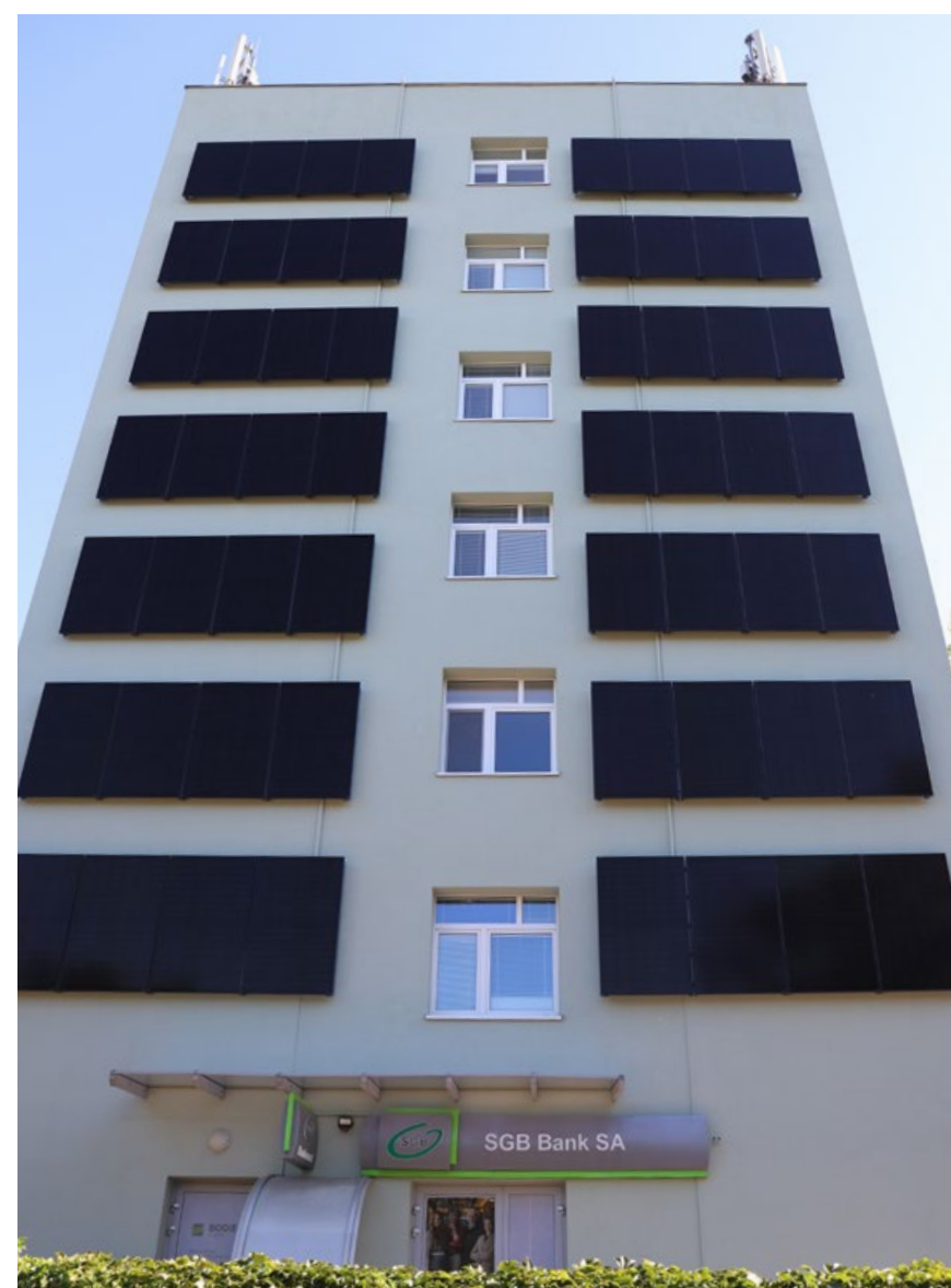
Centrala SGB-Banku. Na części budynku zostały zainstalowane panele fotowoltaiczne.
